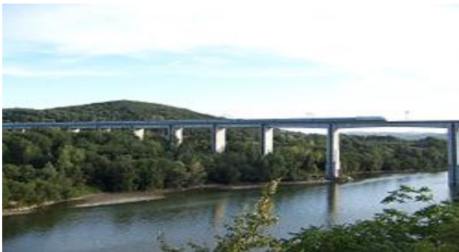
Un ETR 500 sul viadotto di Rondine
